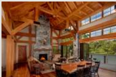
梁柱木结构 (POST & BEAM)
